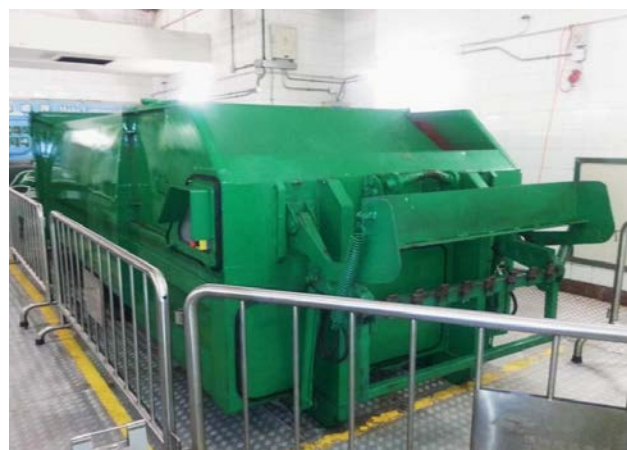
圖4.1.17 環球貿易廣場內的廢物壓縮器 (資料來源：環球貿易廣場)
