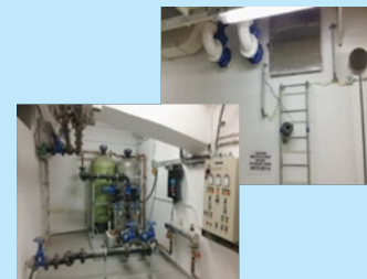
圖3.3.35 雨水回收系統
