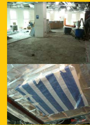
圖3.1.56A 保護現有管道
