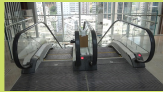
圖3.3.5 為扶手電梯安裝紅外線感應器以達致節能。
