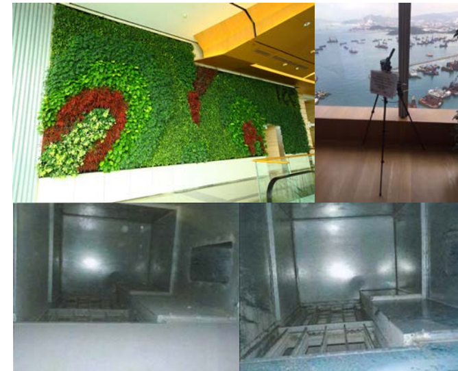
圖3.2.30 室內空氣質素管理計劃 (資料來源：啟勝管理服務有限公司)
