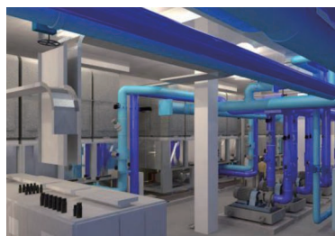
· 冷水機組建築信息模擬技術模型示意圖
