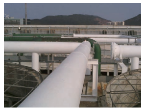
CT#5 現場照片 （有輻射冷卻塗層）：
