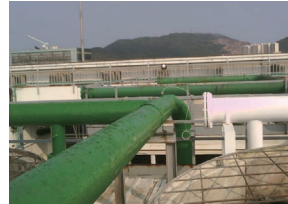
CT#5 現場照片 （有輻射冷卻塗層）：
