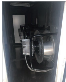
送風機中的電子整流風機
