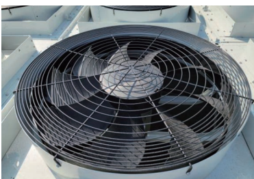
· 更換高靜壓冷凝器風機
