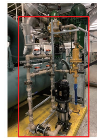
安装了自动管道清洗系统
