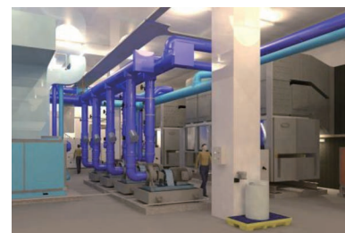
• 冷水机组建筑信息模型模型效果图
