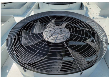
• 更换高静态冷凝器风机
