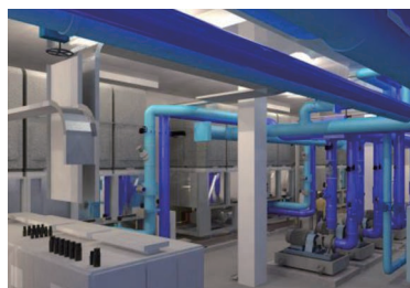
• 冷水机组建筑信息模型模型效果图
