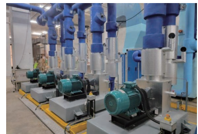
• 将恒速泵改造为变速泵
