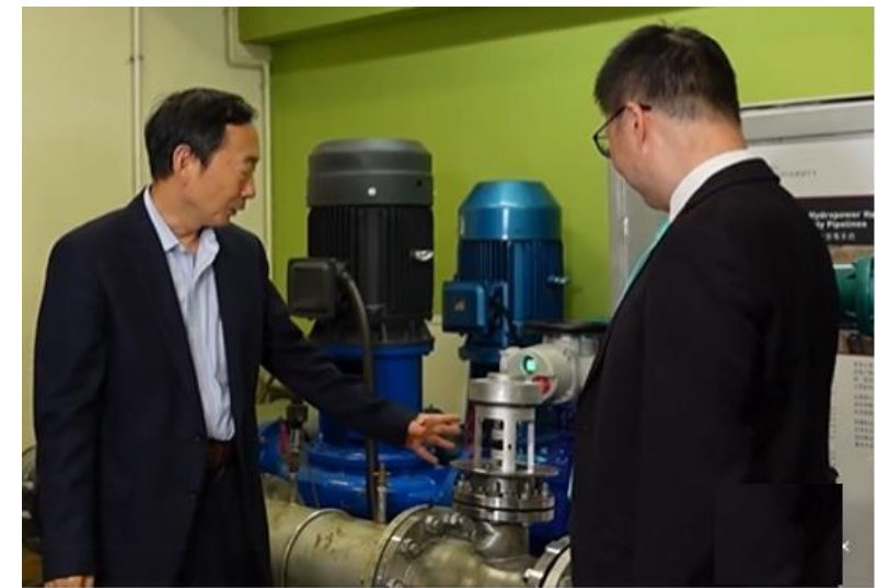
微型水力發電系統，利用輸水管內的水流發電，
